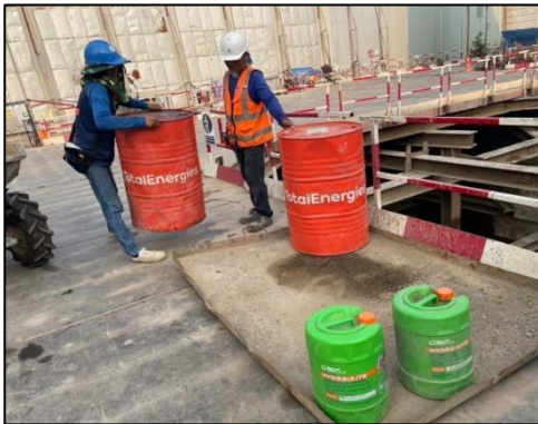
ภาพที่ 20 ใช้น้ำมันหล่อลื่นลดการเสียดสี
