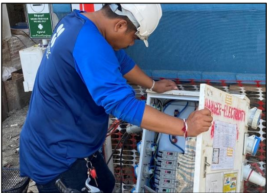
ภาพที่ 50 ติดตั้งแผงควบคุมไฟฟ้าและเครื่องตัดกระแสไฟฟ้า
